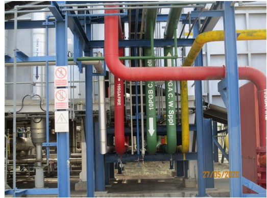
ภาพที่ 2-50 ระบบการทาสีและเครื่องหมาย ตัวอักษร แสดงทิศทางการไหลของระบบท่อและอุปกรณ์ต่างๆ
