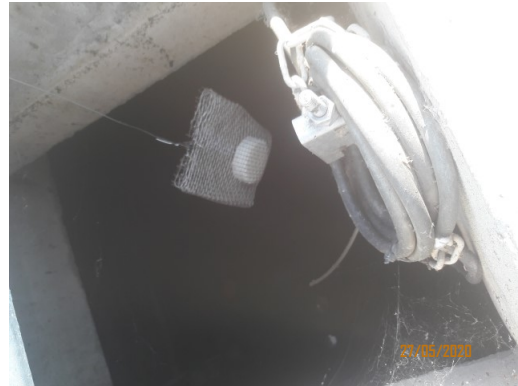
ภาพที่ 2-14 การเติมคลอรีนลงในน้ำทิ้ง
