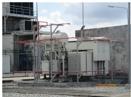
ภาพที่ 2-59 ระบบหัวกระจายน้ำดับเพลิงอัตโนมัติ (Automatic System)
