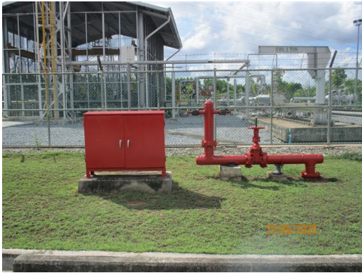
หัวฉีดน้ำดับเพลิง (Yard Hydrant)
