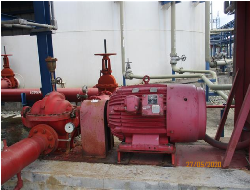
ภาพที่ 2-60 เครื่องสูบน้ำดับเพลิงหลัก
