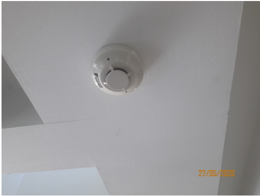
ภาพที่ 2-54 อุปกรณ์ตรวจจับควัน (Smoke Detector)
