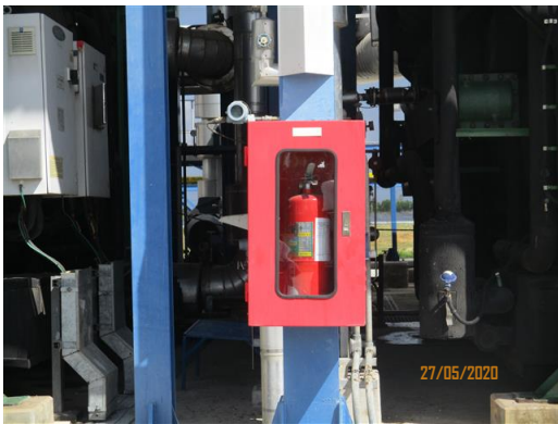
ถังดับเพลิงแบบมือถือ ชนิดสารเคมีแห้ง
