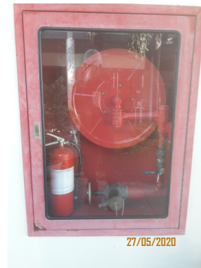
ตู้เก็บสายท่อน้ำดับเพลิง (Fire Hose Cabinet)
