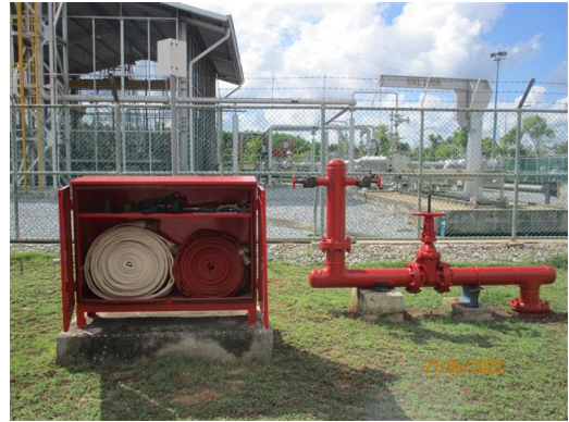
หัวฉีดน้ำดับเพลิง (Yard Hydrant)
