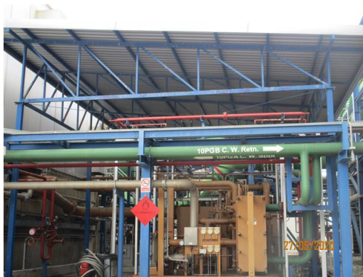
ภาพที่ 2-63 Fire Water Spay System บริเวณ Steam Turbine Generator Bearing Area
