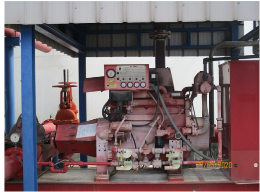
ภาพที่ 2-61 เครื่องสูบน้ำดับเพลิงสำรอง
