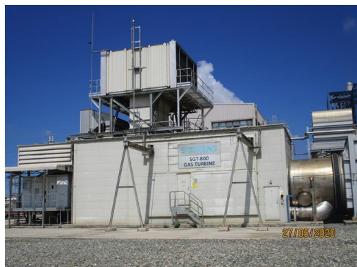
ภาพที่ 2-6 ห้องครอบเครื่องจักร บริเวณห้องเผาไหม้ของเครื่องกังหันก๊าซ
