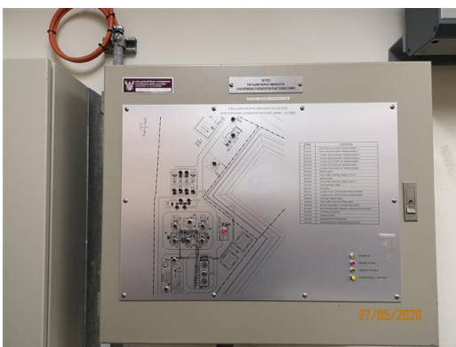
ภาพที่ 2-58 ระบบแจ้งเตือนเหตุเพลิงไหม้
