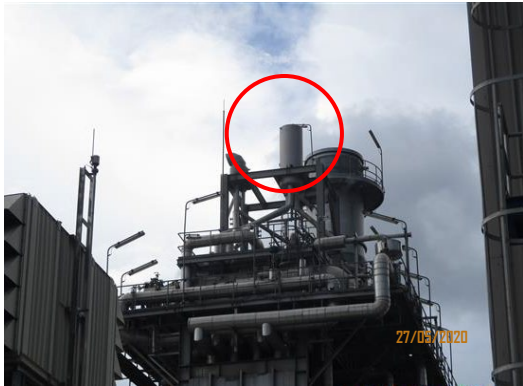
ภาพที่ 2-7 Silencer ที่ Safety Valve
