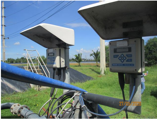
ภาพที่ 2-19 pH Online และ Conductivity Online บริเวณบ่อกักน้ำทิ้ง
