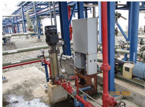
ภาพที่ 2-62 เครื่องสูบน้ำรักษาความดันน้ำดับเพลิง (Jockey Pump)
